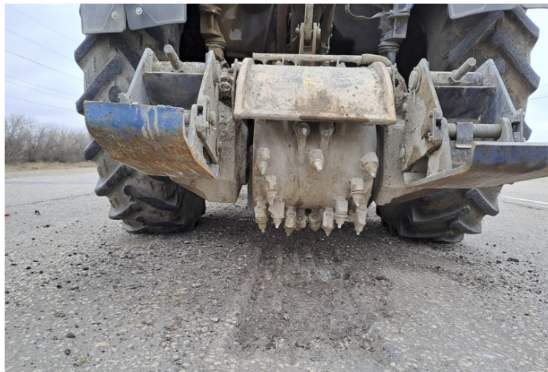
Рисунок 6 – Срезка асфальтобетонного покрытия самоходной холодной дорожной фрезой
