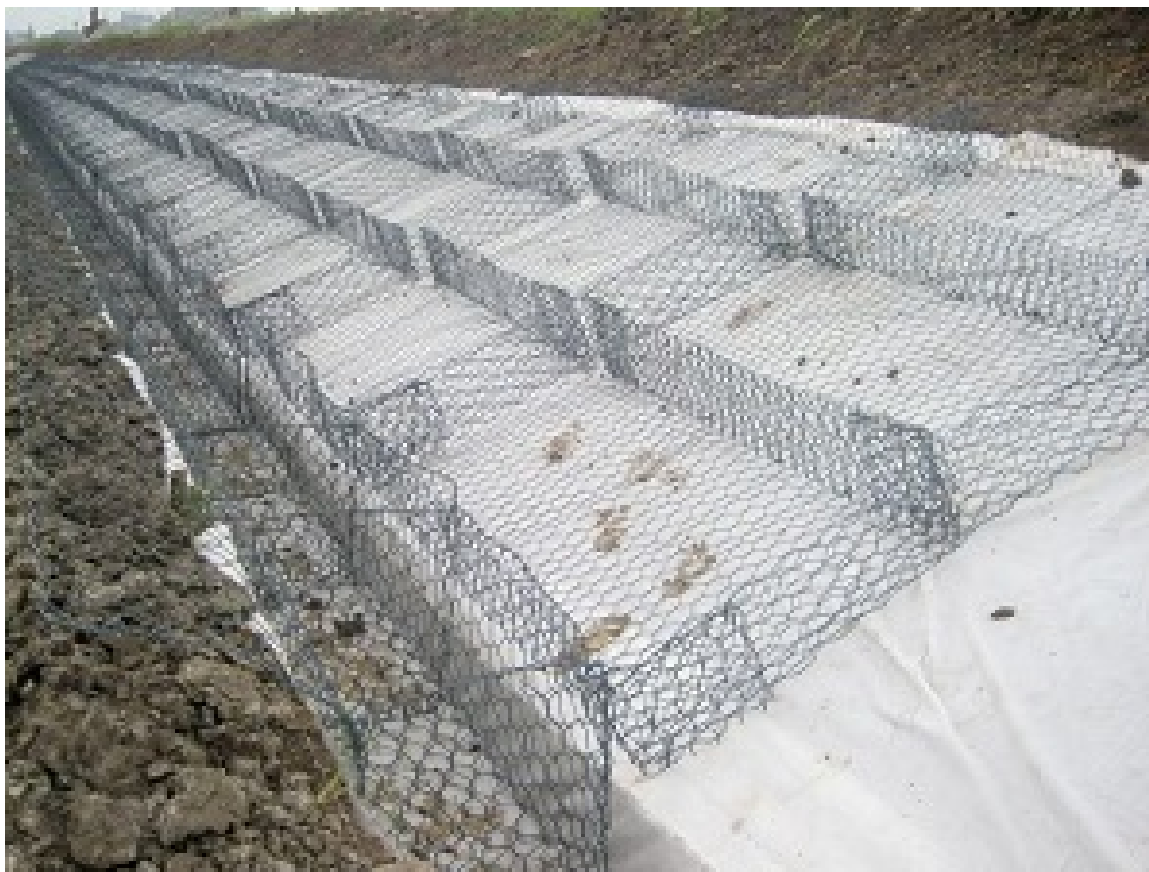
Рисунок 6 – Установка матрацно-тюфячных ГСИ
