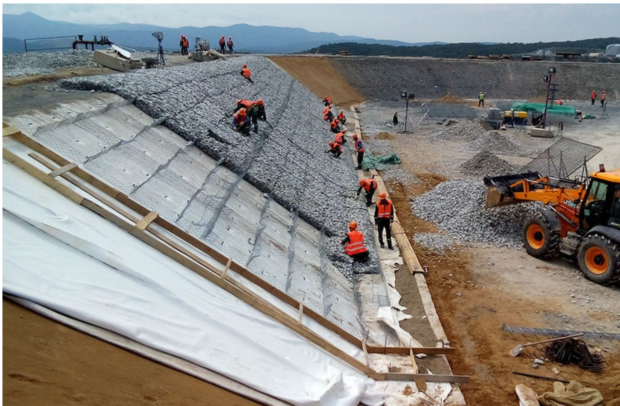
Рисунок 7 – Заполнение матрацно-тюфячных ГСИ камнем
