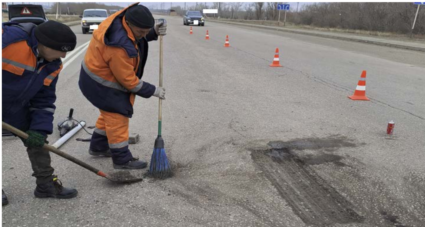
Рисунок 7 – Очистка от пыли ремонтной зоны после фрезерования
