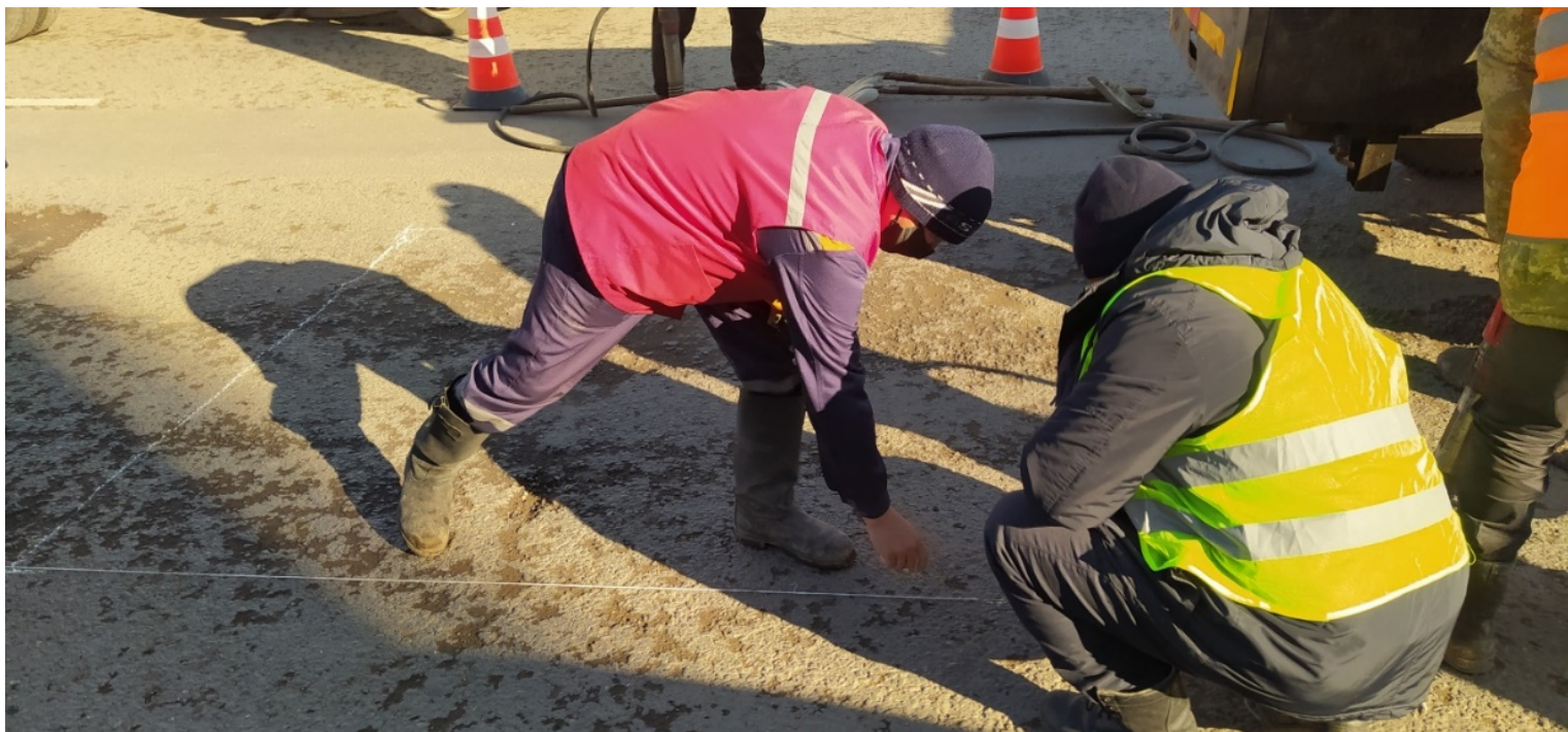
Рисунок 5 – Разметка и маркировка границ ремонта выбоин асфальтобетонного покрытия
