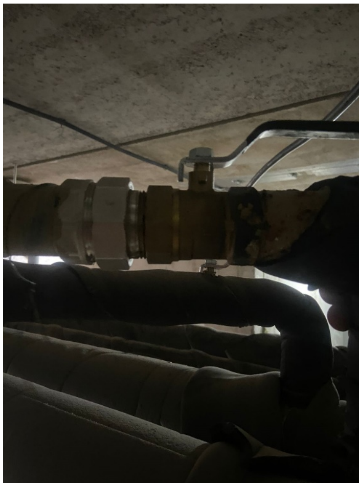
Рисунок 6 - Установка муфтовой запорной арматуры
