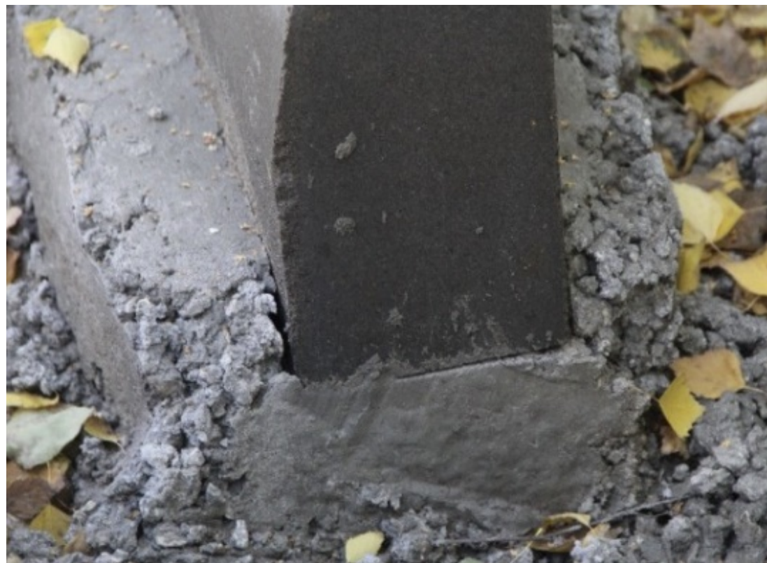
Рисунок 2.7 – Процесс укладки бортовых камней
