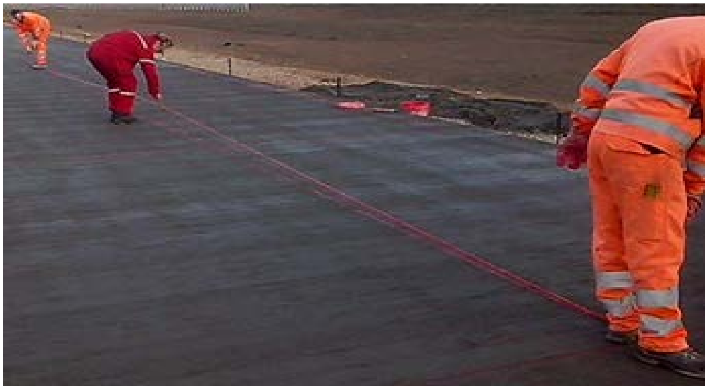
Рисунок 2.1 - Пример разметки продольных линий покрытия контрастной краской перед нарезкой шва
