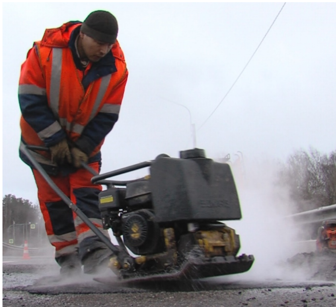
Рисунок 9 – Укладка и уплотнение регенерированной асфальтобетонной смеси на ремонтной зоне
