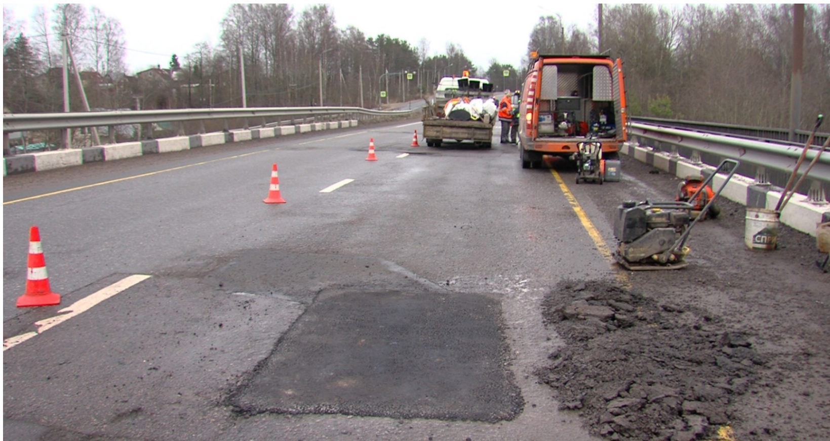
Рисунок 10 – Уложенная регенерированная асфальтобетонная смесь на ремонтной зоне
